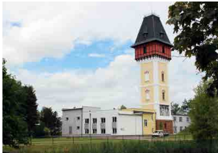
Vodárenská věž – celkový pohled.
