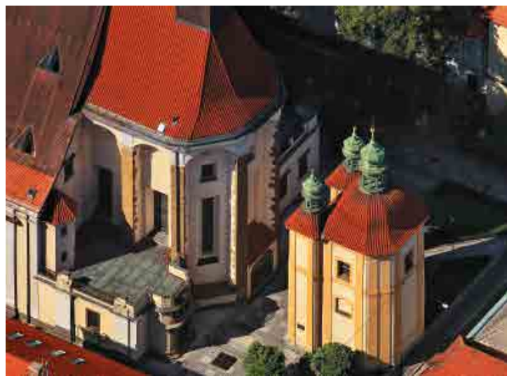
Kaple Smrtných úzkostí Páně.
