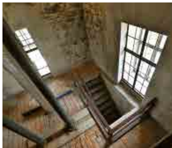
Interiér Vodárenské věže.
