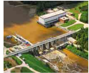
Přehrada Hněvkovice, vpravo odběrný objekt vody pro elektrárnu Temelín.
