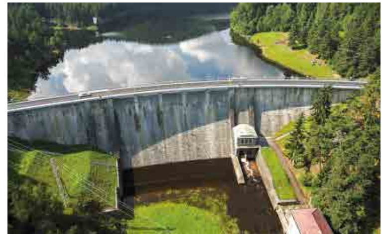
Poslední zděná hráz v Československu – Husinecká přehrada. Dokončena byla roku 1939.
